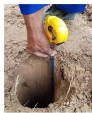
深度1.5m左右，并不小于基础埋深，孔径300mm
