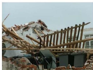
掀翻屋盖、破坏墙体、造成局部倒塌
