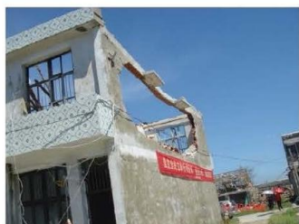
掀翻屋盖、破坏墙体、造成局部倒塌
