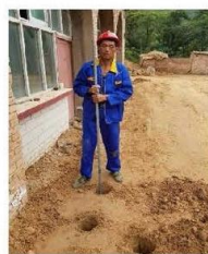
处理宽度为基础外延2m左右
